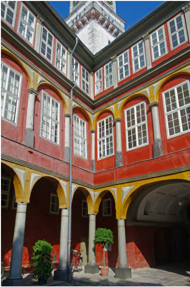
Bild links: Fachwerkansichten vom Schlossinnenhof. Stützen, Bögen und Schwellen aus Holz; Gefache ausgemauert, geputzt und gestrichen. Bild rechts: Fachwerkansichten von der Nordwestseite des Schlosses. Aussteifung der Gefache unter den Fenstern mit Fußbändern.
