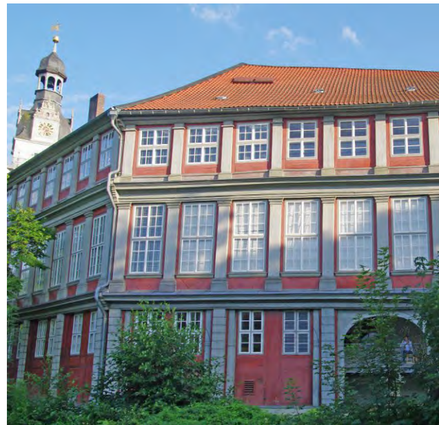
Bild links: Fachwerkansichten vom Schlossinnenhof. Stützen, Bögen und Schwellen aus Holz; Gefache ausgemauert, geputzt und gestrichen. Bild rechts: Fachwerkansichten von der Nordwestseite des Schlosses. Aussteifung der Gefache unter den Fenstern mit Fußbändern.
