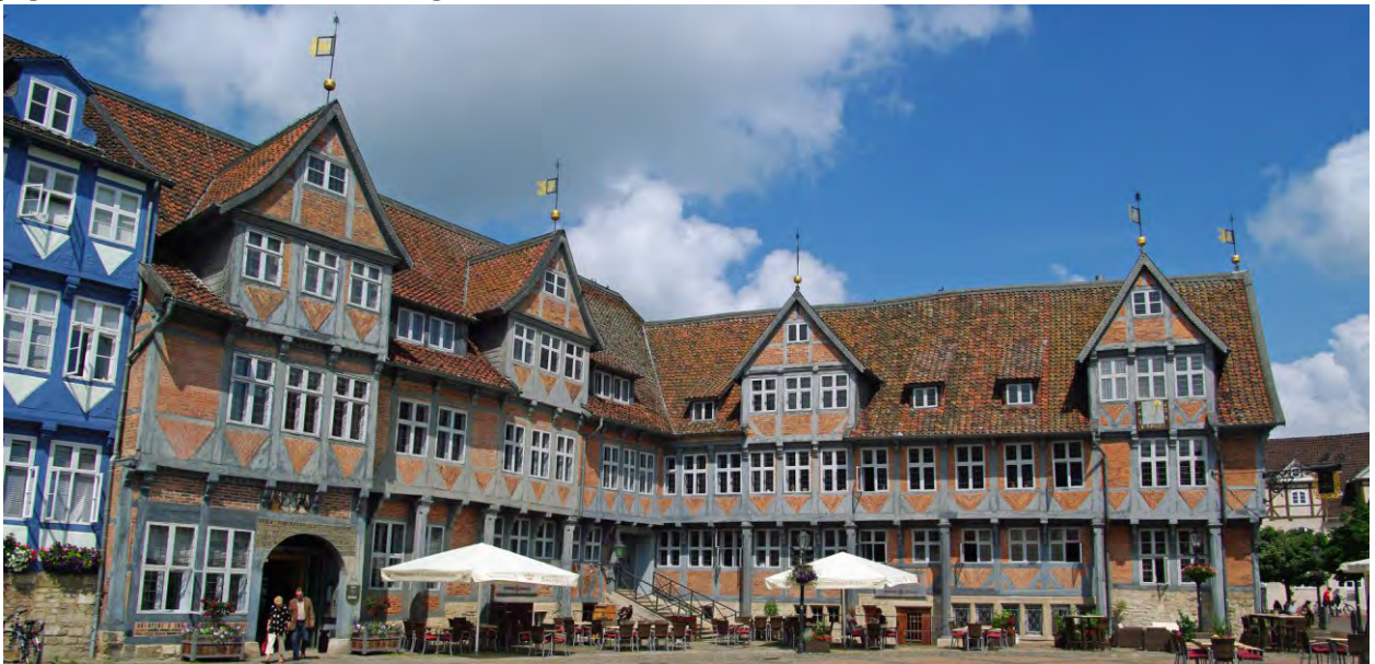
Bild unten: Stadtmarkt 3. Zweigeschossiger Fachwerkbau bestehend aus im Winkel angeordnetem Ratskellerflügel und Waageflügel. Ratskellerflügel rechts: 1599 als Wohnhaus des Färbers und Weinschenken Bauermeister gebaut. Erweiterung nach Osten (4 Achsen?) wohl 1609. Waageflügel links: 1609 vom Rat der Heinrichstadt gebaut.
