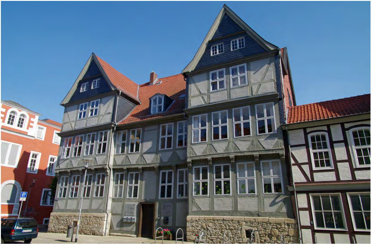
Bild oben: Hofbeamtenhaus Kanzleistraße 2, Baujahr 1597. Hoher Natursteinsockel.
